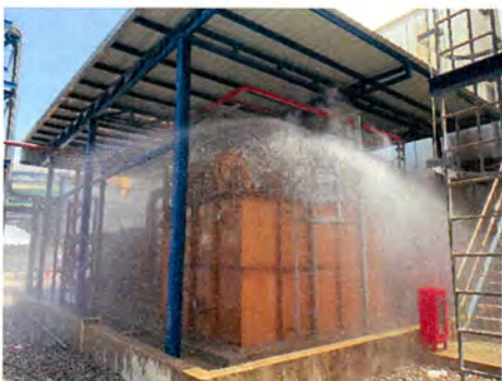
ภาพที่ 2-27 ระบบฉีดน้ำ และหัวฉีดน้ำดับเพลิง
