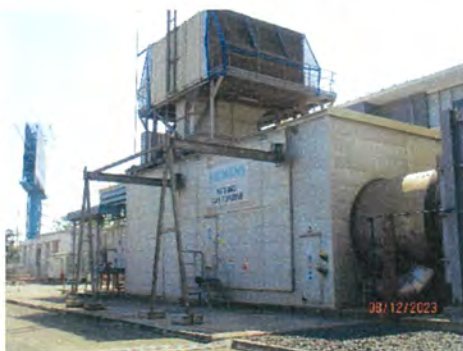
ภาพที่ 2-10 อาคารคลุมเครื่องจักร (Enclosure) บริเวณ Combustion GasTurbine
