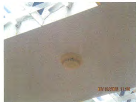
ภาพที่ 2-24 เครื่องตรวจจับควัน
