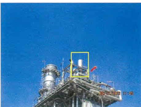
ภาพที่ 2-12 Silencer ที่บริเวณ Relief Valve
