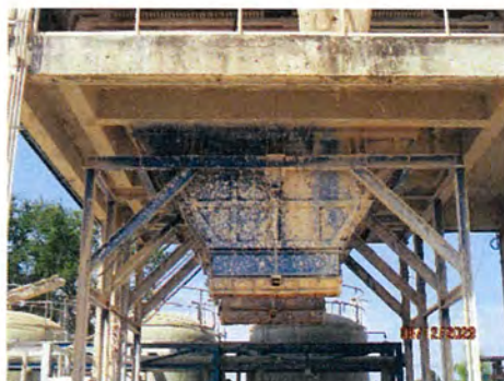
ภาพที่ 2-16 ภาชนะรองรับกากตะกอน จากระบบปรับปรุงคุณภาพน้ำ
