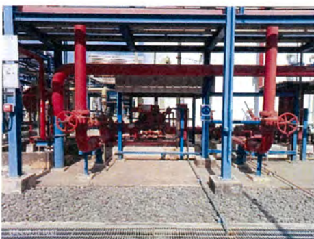
ภาพที่ 2-27 ระบบฉีดน้ำ และหัวฉีดน้ำดับเพลิง
