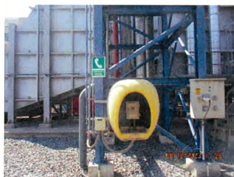
ภาพที่ 2-29 ระบบสื่อสารภายในโรงไฟฟ้า
