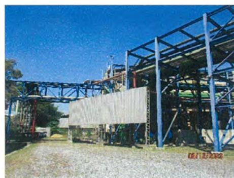
ภาพที่ 2-11 ผนังกันเสียง (Enclosure) บริเวณ Cooling Tower
