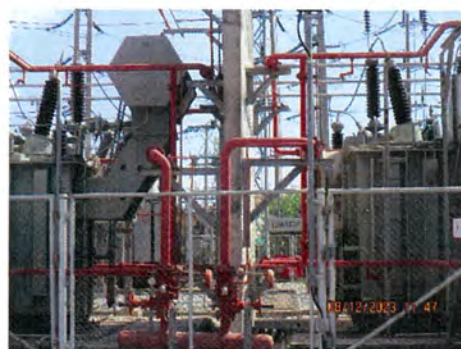
ภาพที่ 2-27 ระบบฉีดน้ำ และหัวฉีดน้ำดับเพลิง
